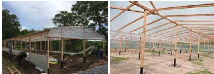
Figura 43. Invernáculos de techo a dos aguas de los viveros provinciales. Fuente: Ministerio de Ambiente
